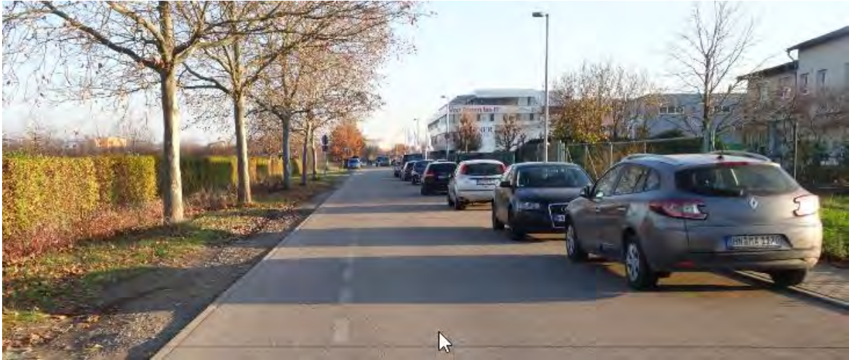
Abbildung 21 - Kleinfeldweg mit abgenutzter Markierung, Foto: VAR+
