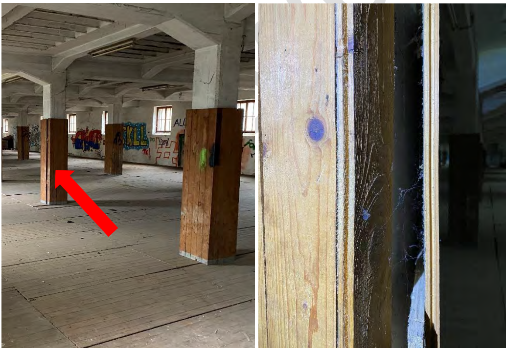
Abbildung 11.4-1. Holzverschalungen der Pfeiler (links) im westlichen Teil der alten Tabakscheune, die Fledermäusen Quartiermöglichkeiten in Form von Spaltenräumen (rechts) bieten.
