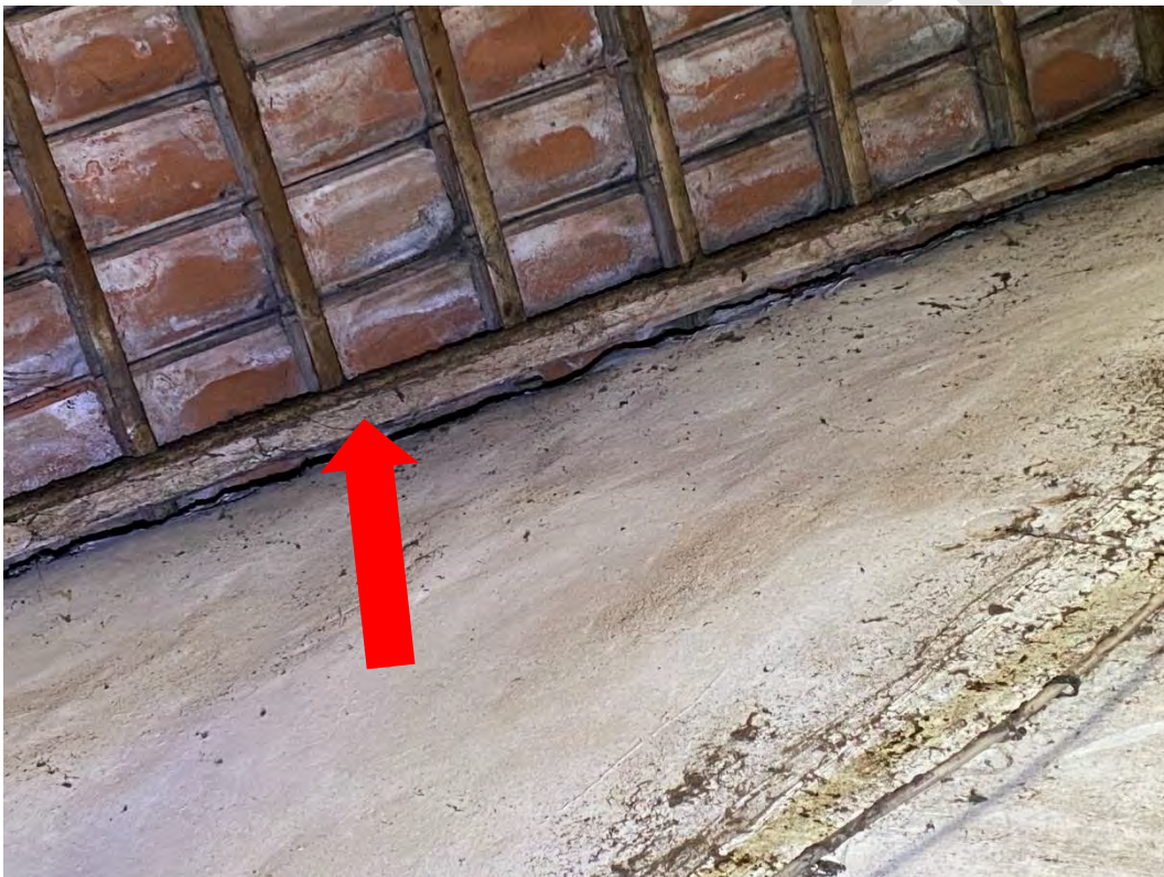
Abbildung 11.4-4. Spaltenraum zwischen Wand und Decke im östlichen Teil der alten Tabakscheune.
