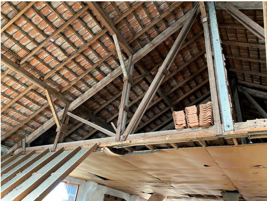
Abbildung 11.4-6. Gebälk und teilweise intakte Decke des Obergeschosses im östlichen Teil der alten Tabakscheune.
