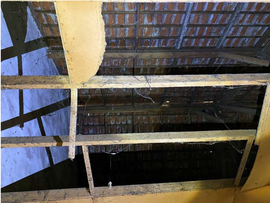
Abbildung 11.4-9. Gebälk über dem Obergeschoss des zentralen Teils der alten Tabakscheune.
