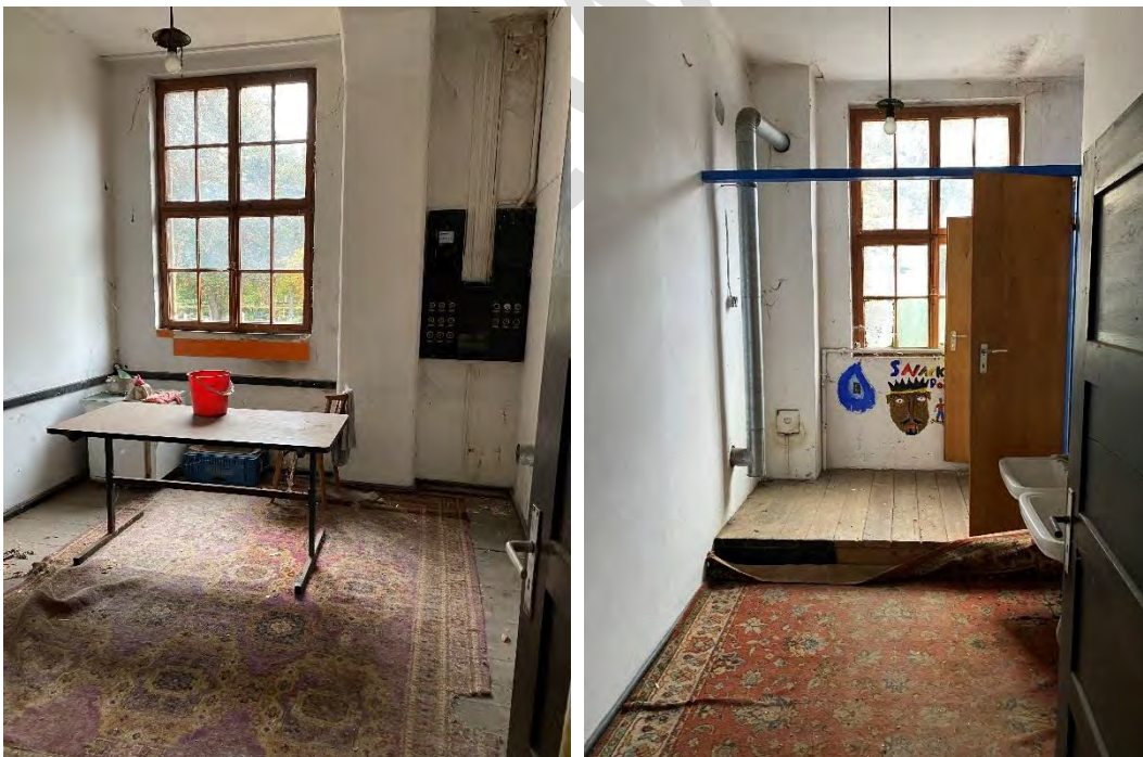
Abbildung 11.4-10. Räume im Obergeschoss des zentralen Teils der alten Tabakscheune.
