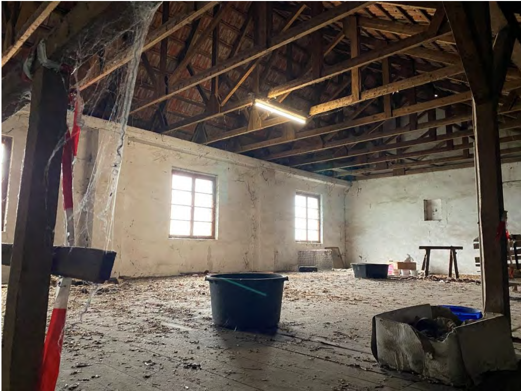
Abbildung 11.4-18. Nordwestlicher Raum der Scheune.
