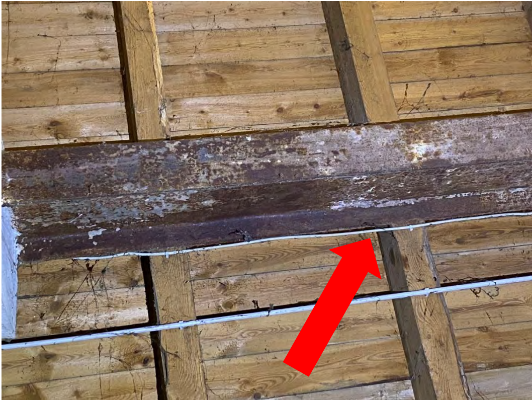
Abbildung 11.4-12 Spaltenraum zwischen Holzbalken im Erdgeschoss des westlichen Teils der alten Tabakscheune.
