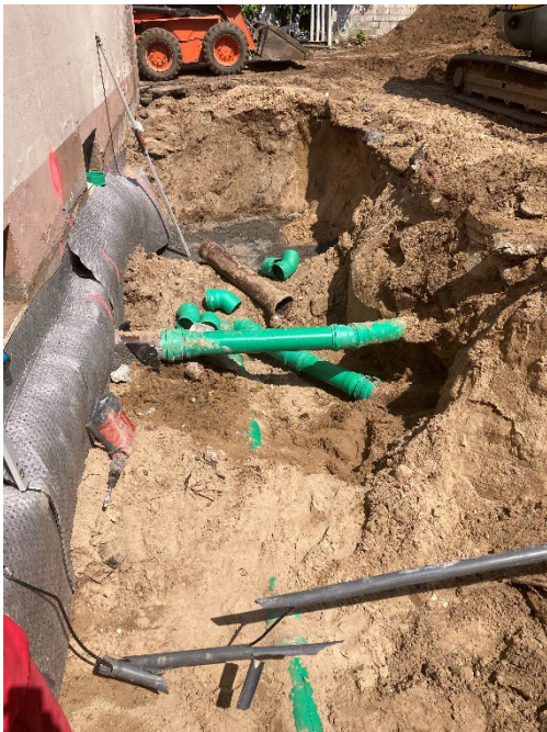
Defekte Entwässerung
