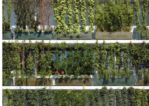
Beispiel für wandgebundene Fassadenbegrünung
