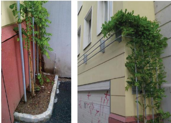
Beispiel für bodengebundene Fassadenbegrünung mit Rankhilfe
