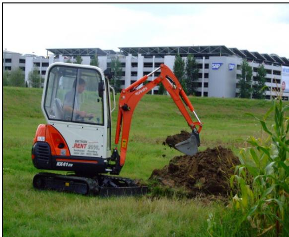
Bild 3: Baggerschurf Sch 2
